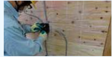
電気配線工事実習
